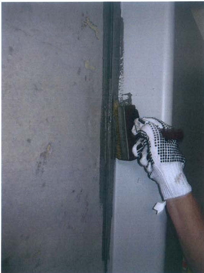
Bild 6: Einstreichen des Flansches der Montageplatte und der angrenzenden Betonoberfläche
