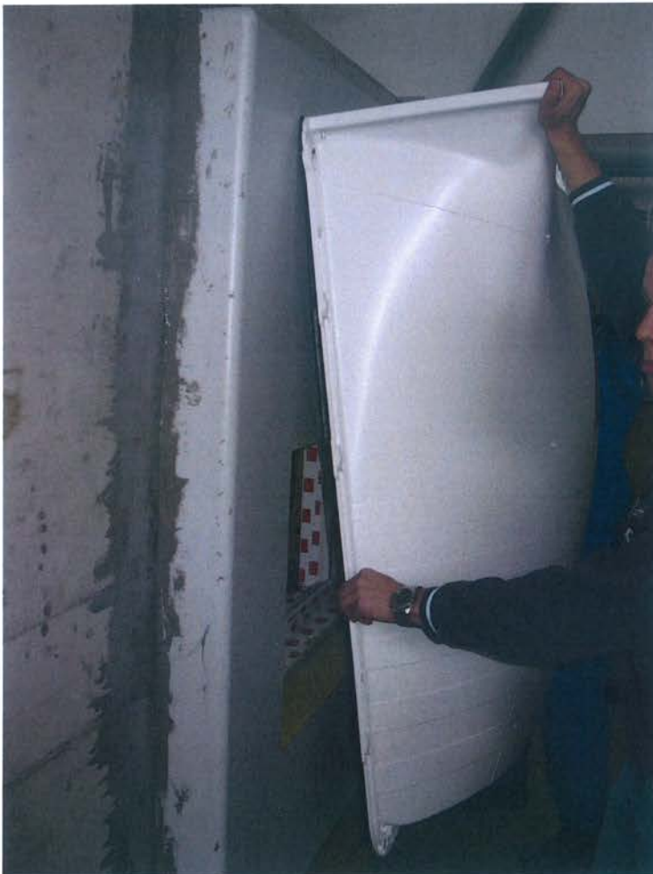
Bild 10: Einhängen des Lichtschachtes an den oberen Schrauben
