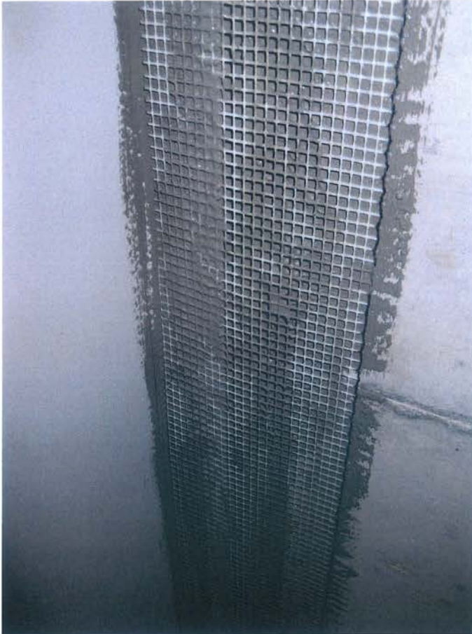
Bild 7: Einlegen des Gittergewebes in die frische Dichtschicht
