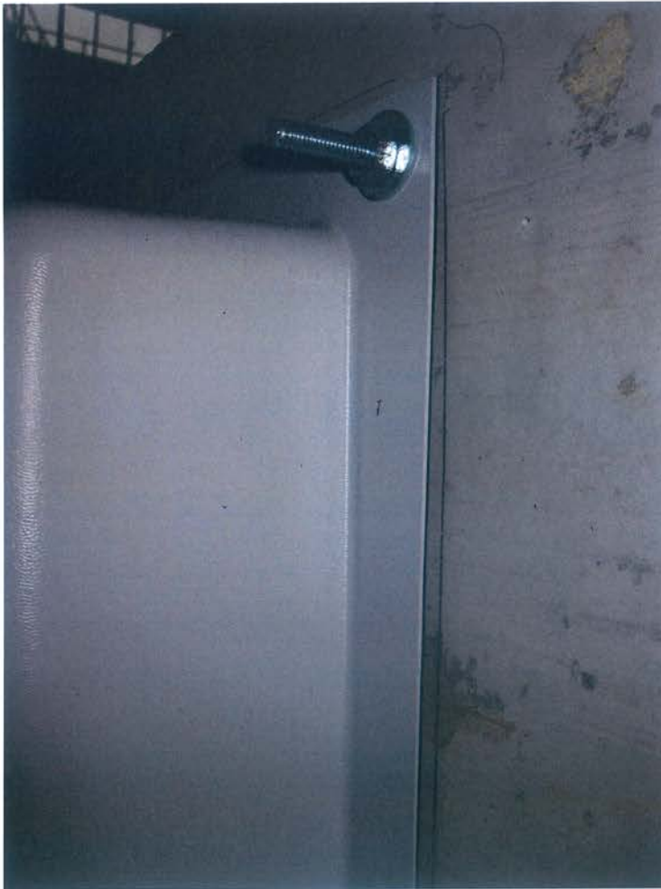
Bild 3: An den oberen, als Montagehilfe dienenden Bolzen eingehängte Montageplatte
