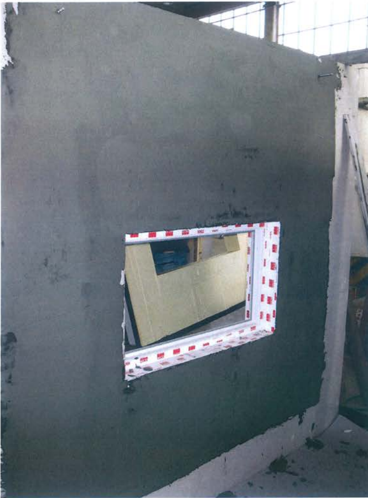
Bild 13: Frisch aufgetragene bitumen- freie Dickbeschichtung
