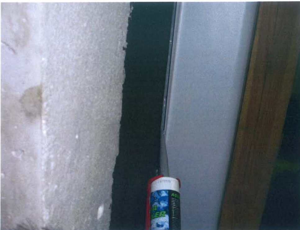
Bild 14: Dichtstoffeintrag unter den Flansch der Montageplatte
