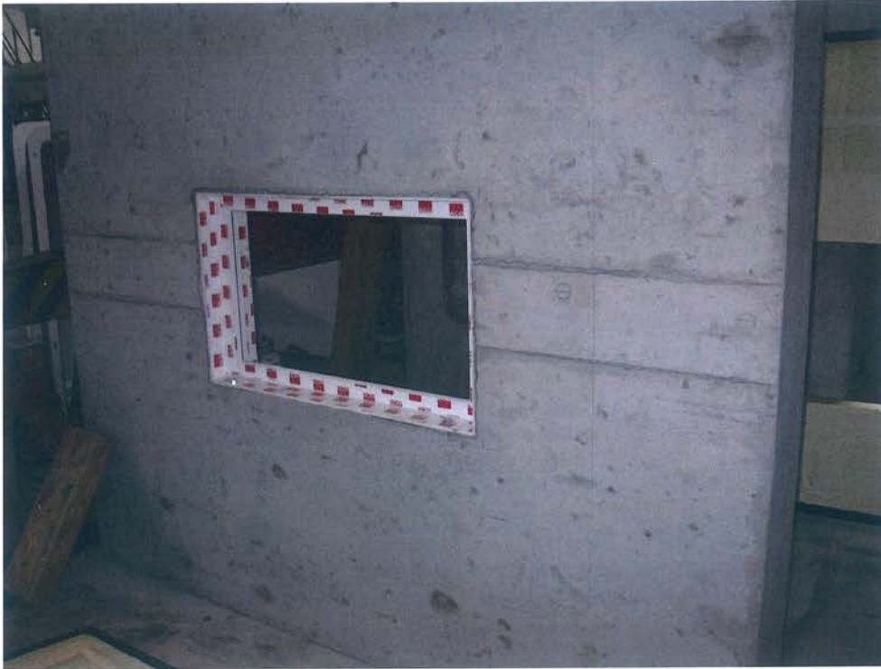
Bild 1: Stahlbetonplatte mit schalungsglatte Oberfläche
