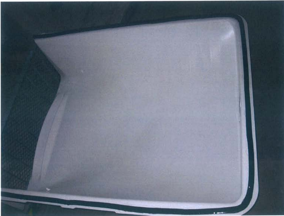
Bild 9: Applikation von ACO Dichtfix auf dem Lichtschachtflansch
