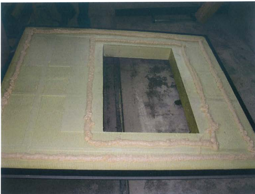
Bild 2: Zur Verklebung des ACO Therm Blocks auf der Betonwand auf der Rückseite strangförmig aufgetragener 1K-PU-Dämmstoffkleber
