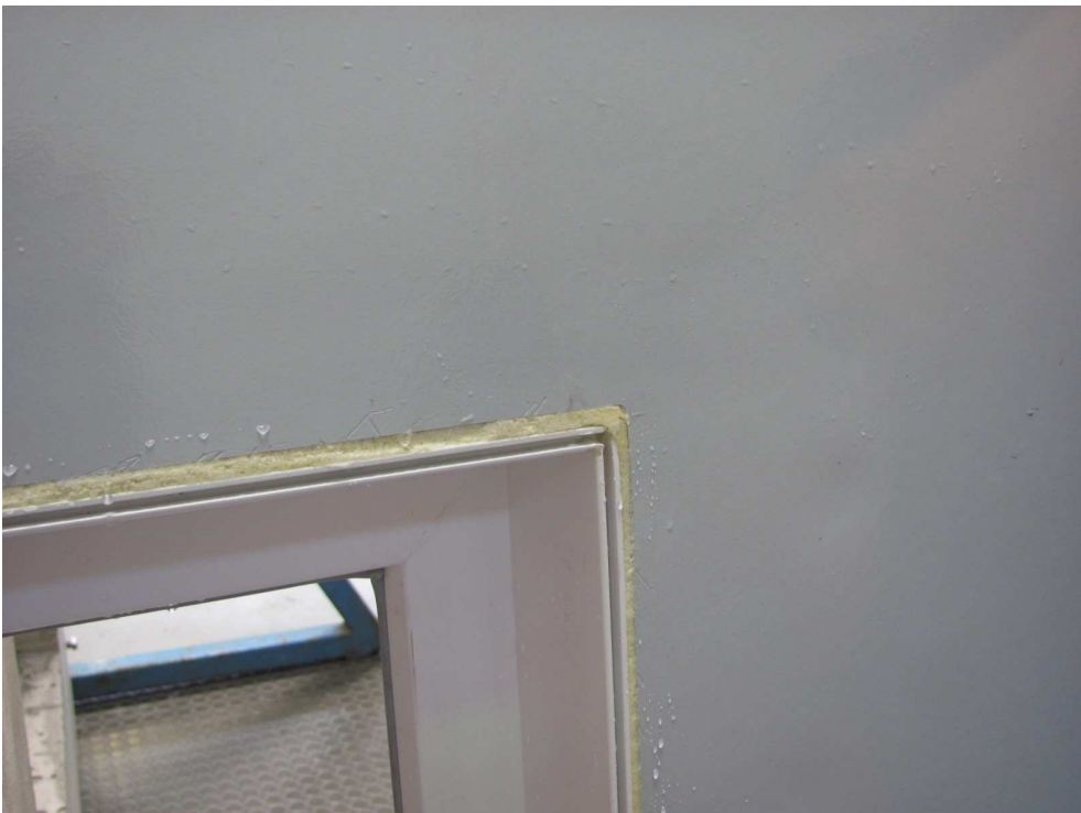
Bild 6 Außenseitige Ansicht Winkelklipsprofile entfernt
