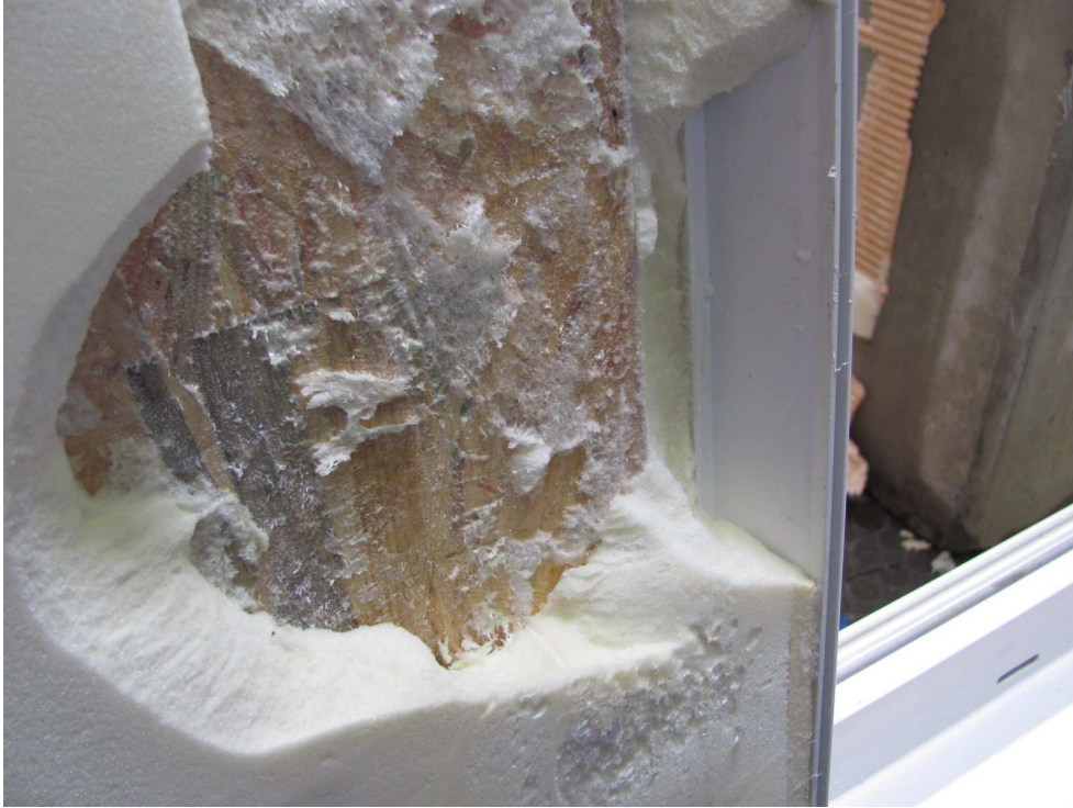
Bild 7 Geöffneter Anschluss zur Kunststofffensterzarge, ohne Wassereintritt
