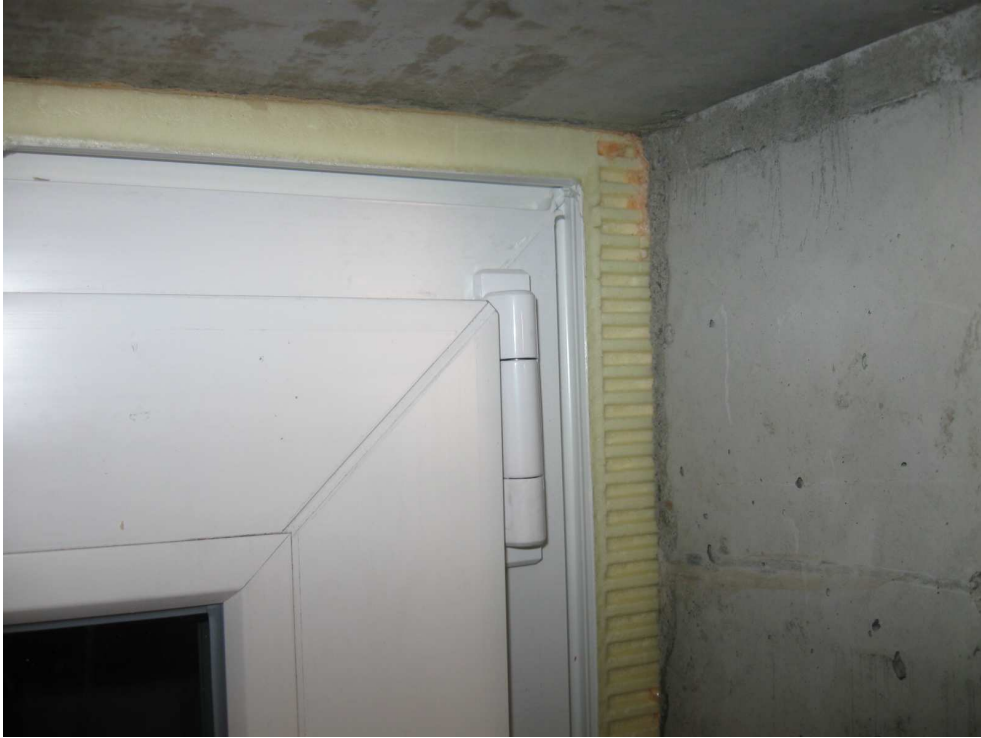
Bild 3 Raumseitige Ansicht obere ECKAusbildung ohne innere Abdichtung
