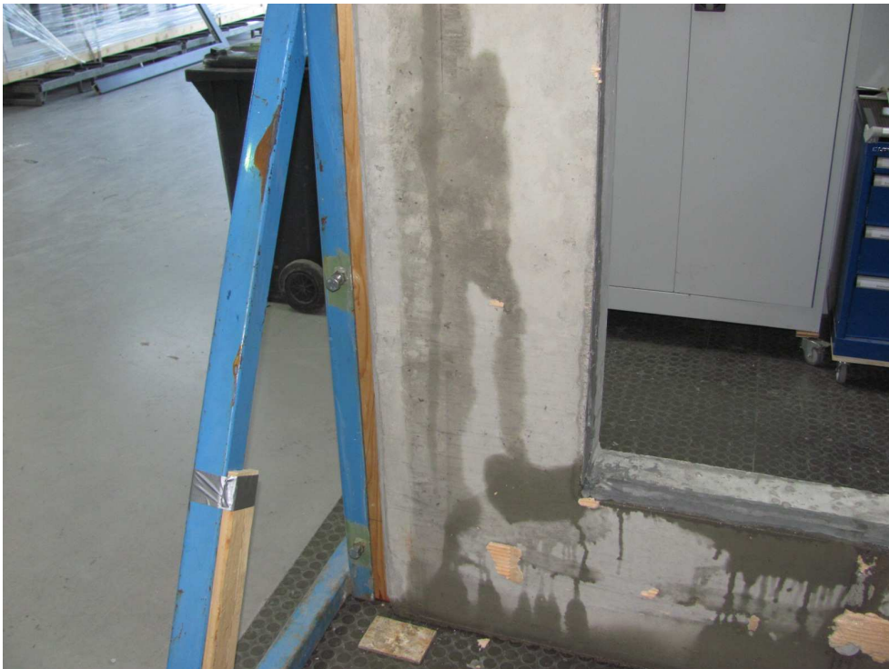
Bild 8 Bauteilrahmen nach Demontage des ACO Therm Blocks. Stelle mit Wassereintritt im Bereich der Klebung zwischen ACO Therm Block und Betonwand
