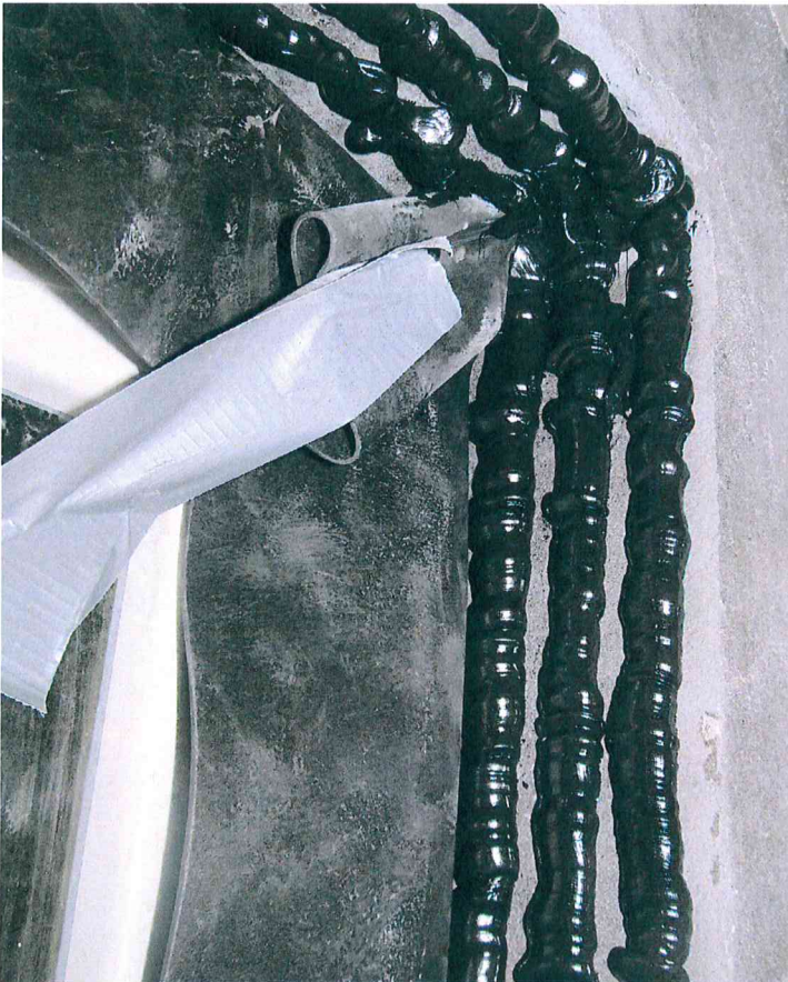
Bild 6: raupenförmig aufgetragener Dichtstoff vor dem Umschlagen und Andrücken der Manschette
