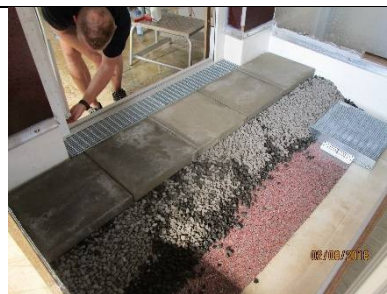
Plattenbelag auf Splittbett
