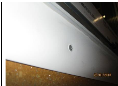
In Unterrastprofil der Schwelle montiertes Edelstahl-Verbundblech
