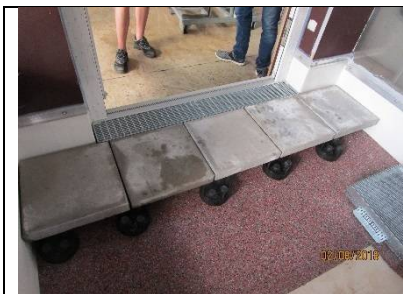
Aufgeständerter Plattenbelag
