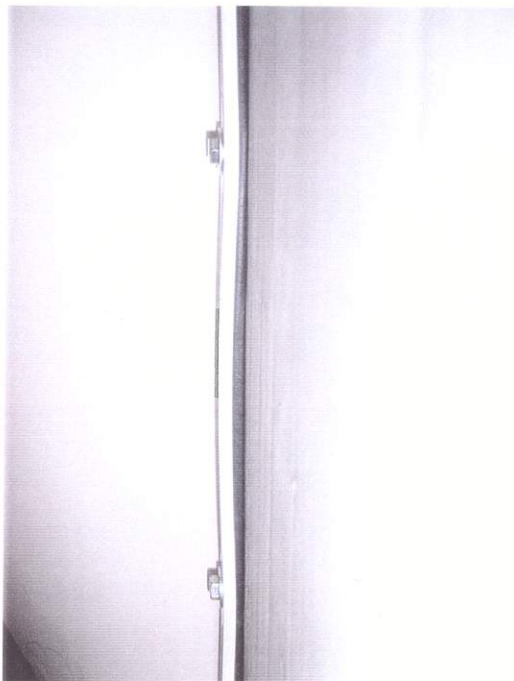
Bild 8: Anfängliche Verformung des Lichtschachtflansches im Bereich zwischen den Verschraubungspunkten
