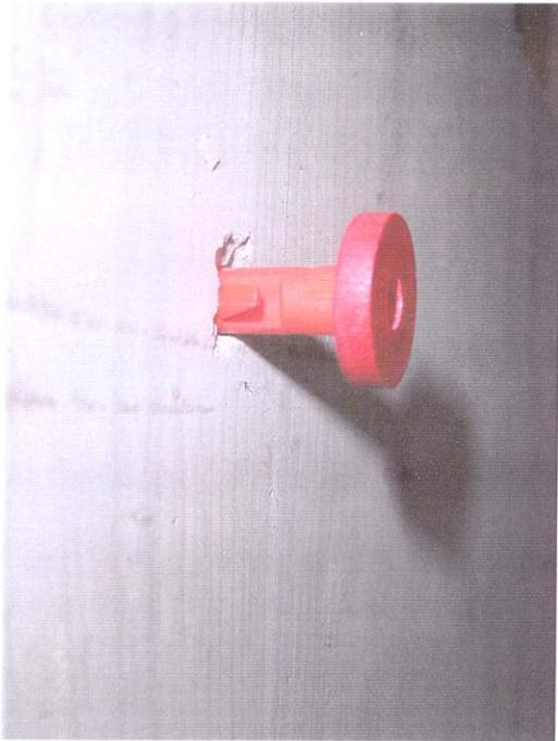
Bild1: Kunststoffdübel mit aufgesteckter Distanzscheibe
