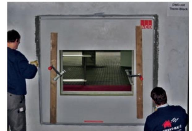
// 3. Montage auf Perimeterdämmung
