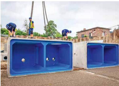
Modulare Betonfertigteile für ein Regenrückhaltebecken (Foto: ACO)
