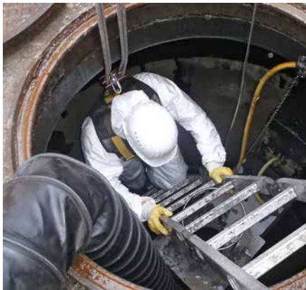
Einstieg in einen Schacht (GET)
