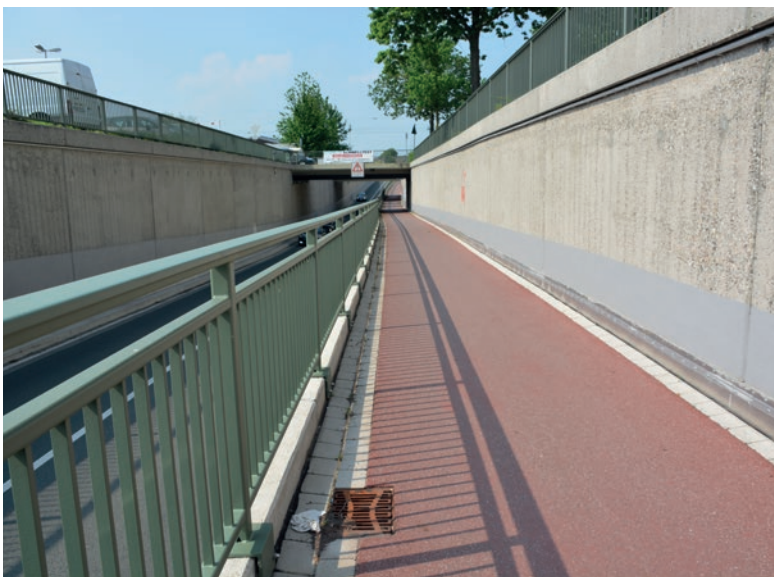
Barrierefreier Geh- und Radweg nach Fertigstellung
