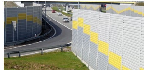
beengte Verhältnisse (z. B. Lärmschutzwände)
