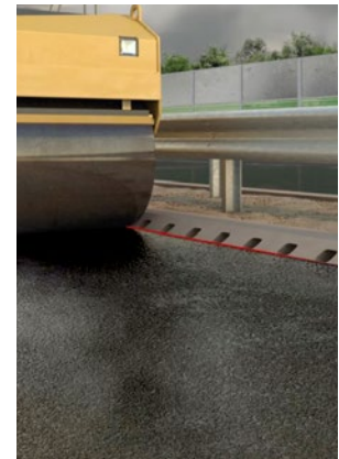
Optimale Orientierung für Verdichtungsgerät
