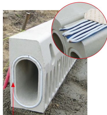
■ Dichtstoff in Nut
