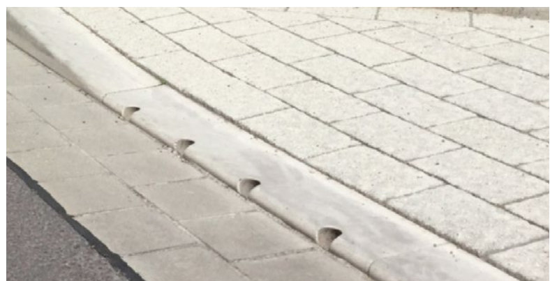
Mittelsteine mit Einlauföffnungen
