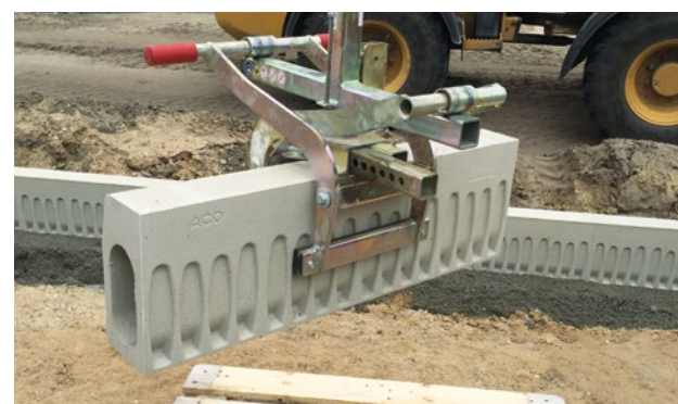
■ Zangen erleichtern das Versetzen der Elemente
