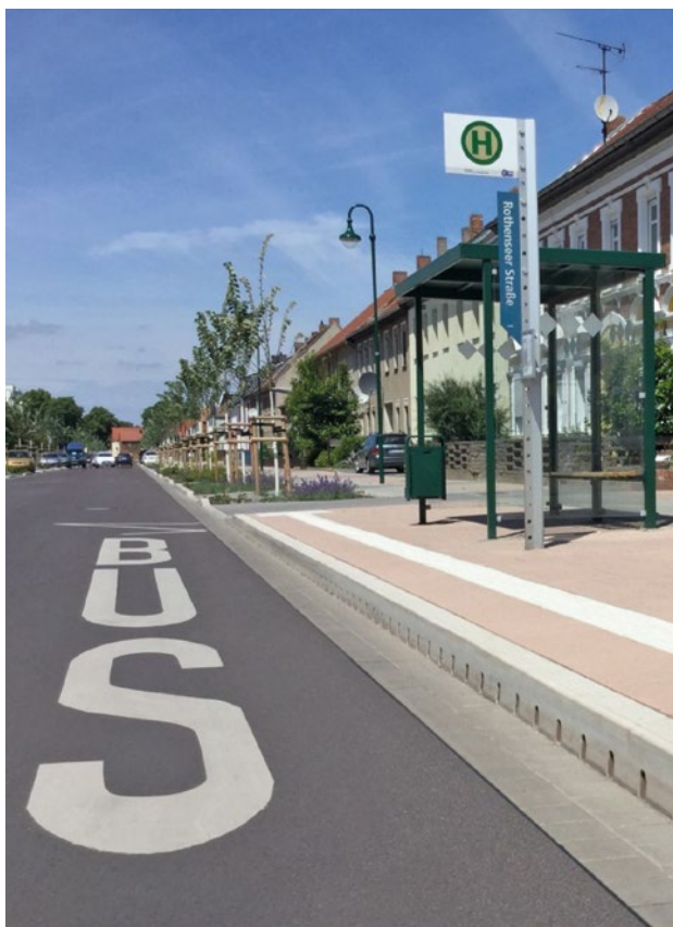
Barrierefreies Einsteigen in den Bus durch den 18-cm-Hochbord
