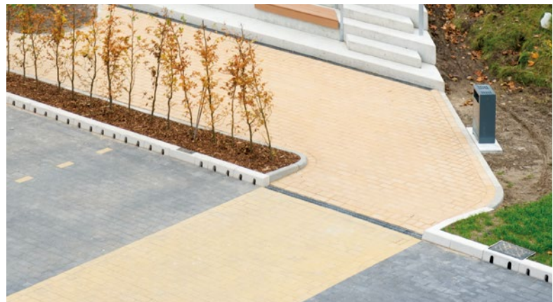
Ein Strang mit Einlaufkasten schützt die Kanalisation vor Verschmutzung
