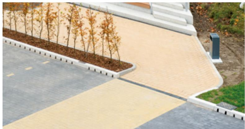
Ein Strang mit Einlaufkästen schützt die Kanalisation vor Verschlämmung
