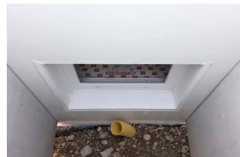
ACO Betonlichtschacht mit Rückwand und Perimeterabdeckrahmen
