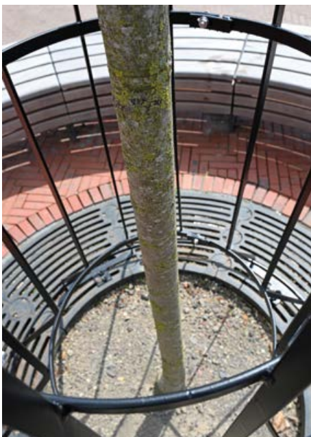
Baumschutzgitter mit mitgelieferten Befestigungshaken auf Baumschutzrost montieren
