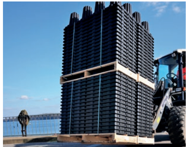
Die Stapelbarkeit des modularen Rigolensystems ermöglicht platzsparendes Transportieren und Lagern vor dem Einbau.
