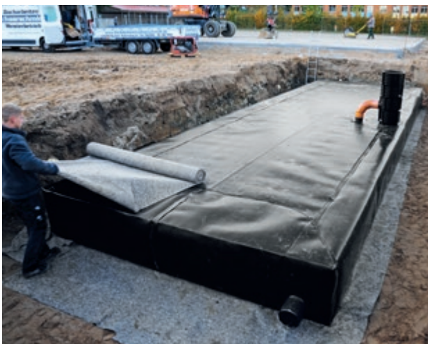
Durch die Ummantlung mit einer hochwertigen PEHD-Abdichtungsbahn entsteht schnell ein unterirdischer Löschwasserbehälter
