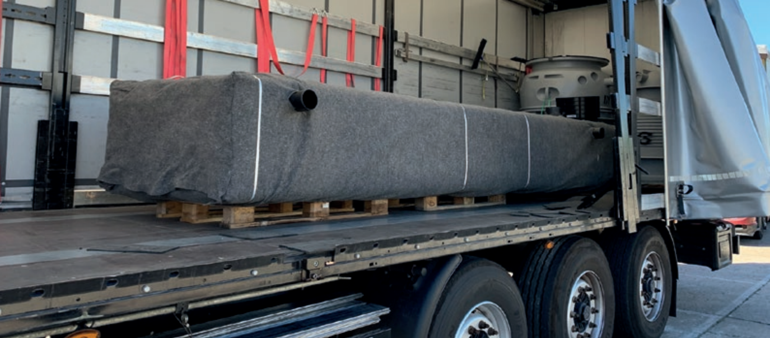
Vorkonfektionierte Fertigrigole mit integriertem Drosselorgan auf dem Weg zur Baustelle.
