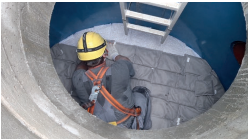
Einbau des Schwermetallfilters
