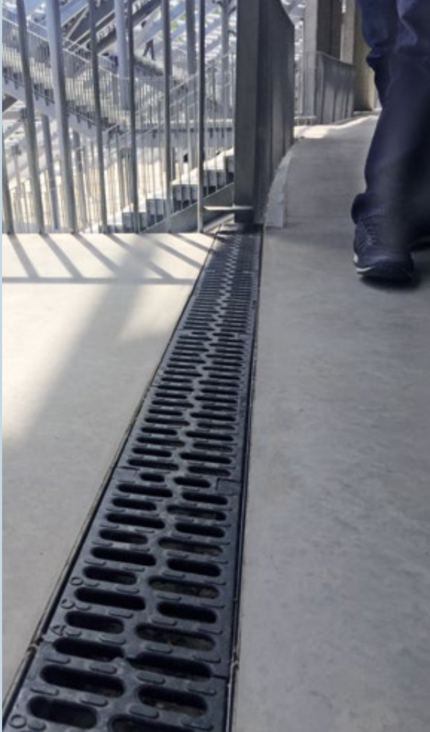
ACO DRAIN® Multiline light entwässert im Umlauf des Stadions
