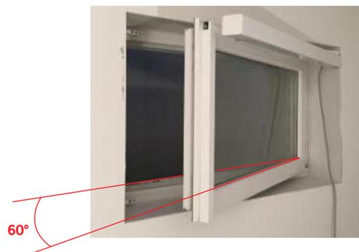
Der Antrieb öffnet den Flügel weiter als 60°. Die lichte Öffnung des Leibungsrahmens kann ohne weitere Berechnungen als Bemessungsgröße verwendet werden.
