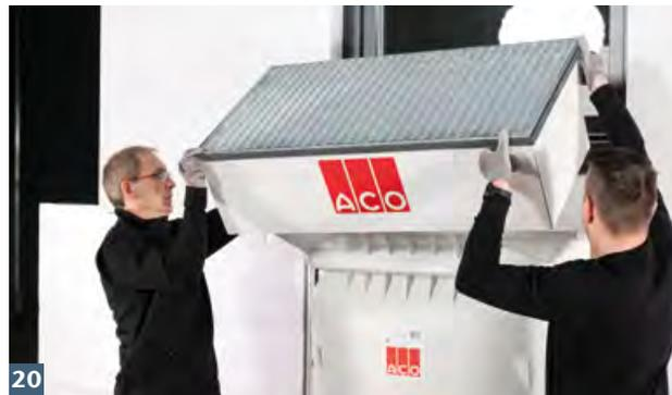
**20** ACO Aufstockelement in Wandanschlussprofile einführen und in Lichtschachtrostaufgabe drücken.
