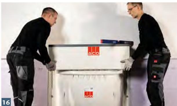
Aufstockelement über Lichtschart schieben und ausrichten.
