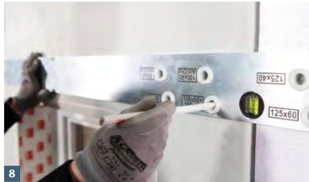
**8** Obere Lichtschachtbefestigungspunkte mit ACO Bohrschablone anzeichnen.
