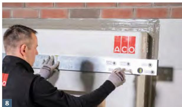
**8** Obere Lichtschachtbefestigungspunkte mit ACO Bohrschablone anzeichnen.
