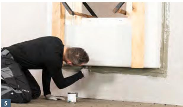
5 ACO Therm® Block umlaufend in 2 Arbeitsgängen abdichten. Übergang von ACO Therm® Block zur Kellerdecke z.B. mit Aqua Blocker gegen Hinterläufigkeit abdichten.
