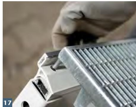
Rostzapfenlöcher ins Aufstockelement bohren und Rost einlegen.
