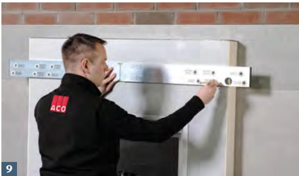
**9** Obere Lichtschachtbefestigungspunkte mit ACO Bohrschablone anzeichnen.
