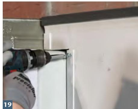
ACO Aufstockelement mit Lichtschacht und Wandanschlussprofilen verschrauben.
