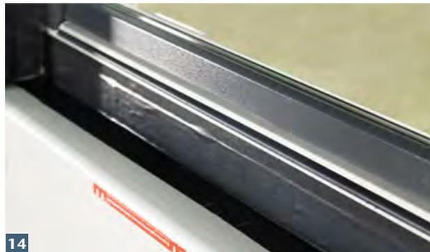
**14** Abdichtung zur Terrassentür z.B. mit KSK-Bahn oder Aqua Blocker herstellen. Kondensatöffnung ggf. aussparen.
