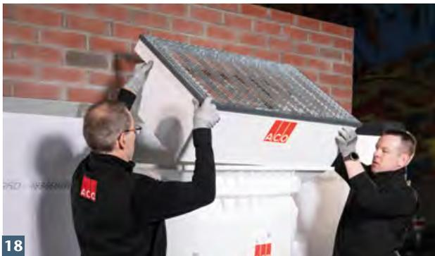
ACO Aufstockelement in Wandanschlussprofile einführen und in Lichtschachtrostaufgabe drücken.
