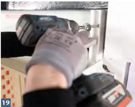
**19** Wandanschlussprofile vom Aufstockelement abnehmen und mit ACO Therm® Block verschrauben.
