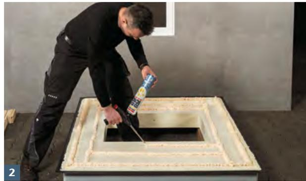
2 Dämmplattenkleber aufsprühen.
