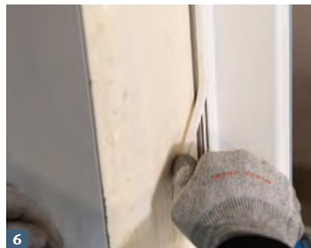
6 Kanthölzer und Montagehilfen entfernen. Schalungsdichtung aus ACO Therm® Leibungskellerfenster entfernen.
