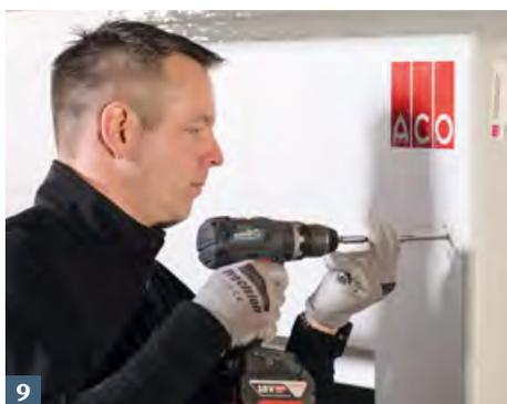
**9** Die beiden oberen Schrauben für die Lichtschachtbefestigung eindrehen.
