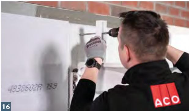
Wandanschlussprofile vom Aufstockelement abnehmen und mit ACO Therm® Block verschrauben.
