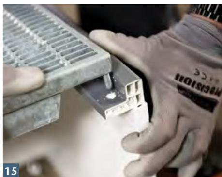
Rostzapfenlöcher in das Aufstockelement bohren und Rost einlegen.
