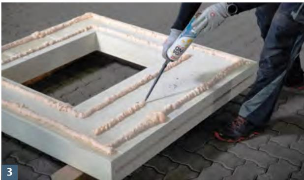
3 Dämmplattenkleber aufsprühen.
