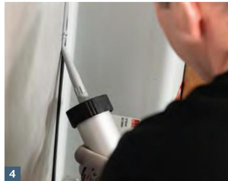
4 ACO Therm® Block umlaufend mit Aqua Blocker aus Kartusche abdichten.
