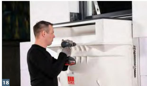
Aufsatzelement mit werkseitiger Aussparung für Lüftungskasten mit dem ACO Therm® Lichtschacht verschrauben.
