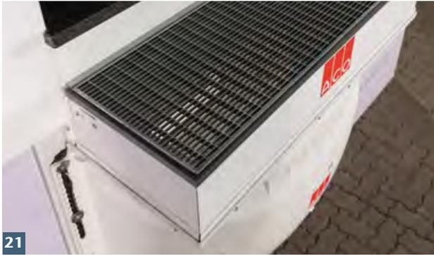
ACO Lichtschachtrost entnehmen. ACO Adapterwinkel an Lichtschachtrost anschrauben. Rost wieder in Aufstockelement legen.
