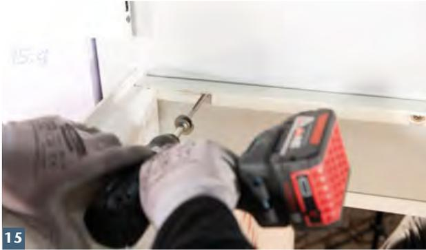
Wandanschlusswinkel für wandseitige Auflagerung des Aufstockelements montieren.
