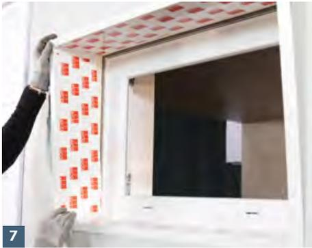
**7** ACO Dämmungsanschlussprofil in Nut des ACO Therm® Leibungskellerfensters einklicken.
