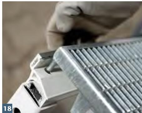
**18** Rostzapfenlöcher ins Aufstockelement bohren und Rost einlegen.
