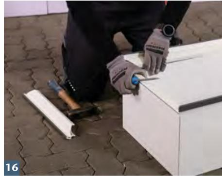
Rostauflageprofil von Aufstockelement entfernen.
