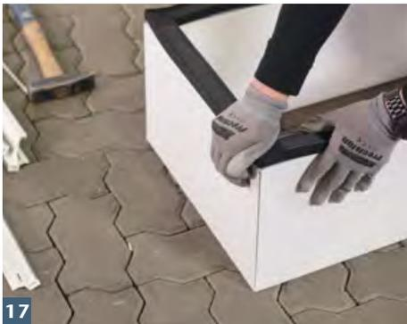
Dichtungsrahmen auf Aufstockelement aufstecken.
