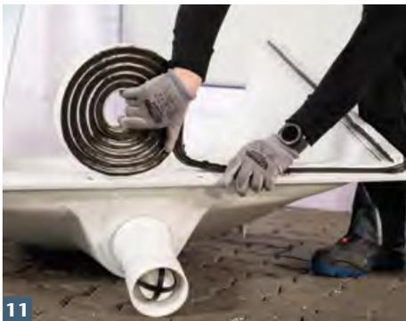
**11** Selbstklebendes ACO Dichtfixband auf sauberen Lichtschachtflansch aufkleben.
