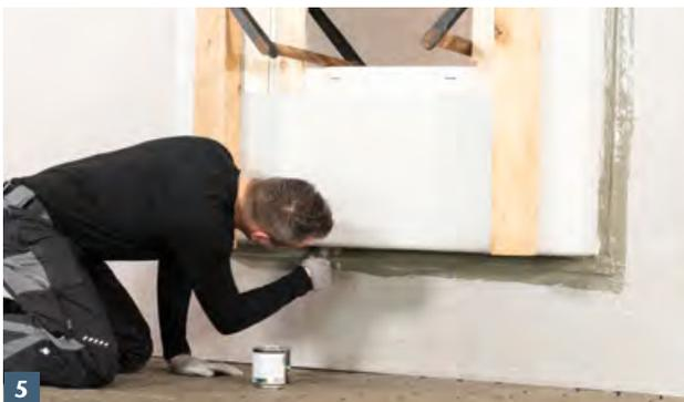
5 ACO Therm® Block umlaufend in 2 Arbeitsgängen andichten. Übergang von ACO Therm® Block zur Kellerdecke z.B. mit Aqua Blocker gegen Hinterläufigkeit abdichten.
