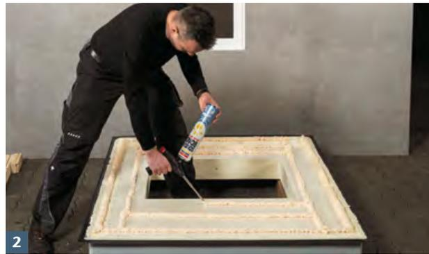
2 Dämmplattenkleber aufsprühen.
