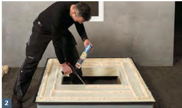
2 Dämmplattenkleber aufsprühen.
