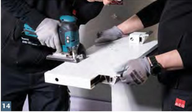
ACO Aufstockelement und Wandanschlussprofile mit Stichsäge an rückspringende Klinkerfassade anpassen.
