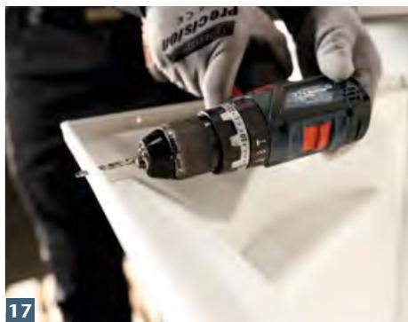
ACO Therm® Lichtschart für Montage des Aufstockelements vorbohren.
