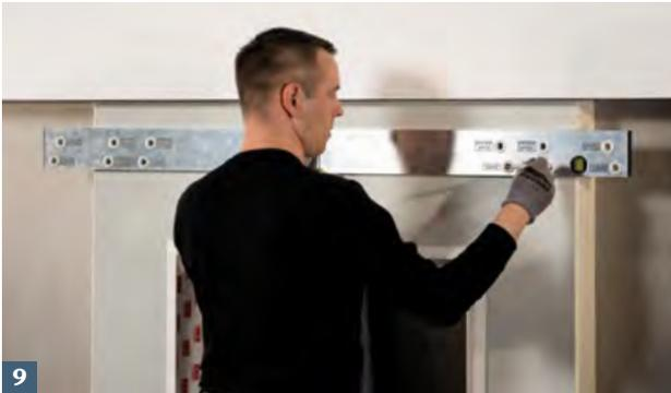
**9** Obere Lichtschachtbefestigungspunkte mit ACO Bohrschablone anzeichnen.
