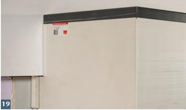
Wandanschlussprofile gegen Dämmung schieben und Rost einlegen.
