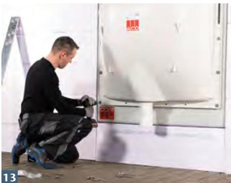
**13** Schrauben rundum mit Kontakt zum ACO Dichtfixband eindrehen.
