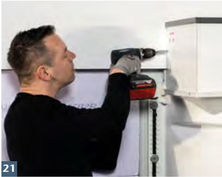
ACO Aufstockelement mit Wandanschlussprofilen verschrauben.
