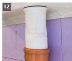
KG-Rohr DN 100 muffenseitig anschließen. Dichtung mit Gleitmittel bestreichen. Das KG-Rohr muss im weiteren Verlauf im Gefälle zum Kanal verlegt werden. Bitte Hinweis auf Seite 2 beachten.
