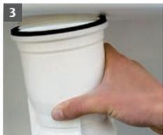
Den Einschraubring von oben durch die Lichtsacht-Entwässerungsöffnung führen. Den Grundkörper von unten auf den Einschraubring schrauben, dabei auf den korrekten Sitz des Gewindes achten, Grundkörper soweit aufschrauben, bis die Dichtung am Lichtsacht anliegt. Mit dem Einschraubring festziehen, dabei den Grundkörper gegenhalten.
