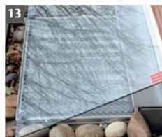
Während der Rückstauphase kann die Entwässerung von anfallendem Oberflächenwasser nicht erfolgen. Aus diesem Grund empfehlen wir den Einsatz der ACO Lichtsachtabdeckung. Wichtig für die Außengestaltung: Der angrenzende Oberflächenbelag am Lichtsacht muss so ausgebildet werden, dass kein Oberflächenwasser in den Lichtsacht laufen kann.
