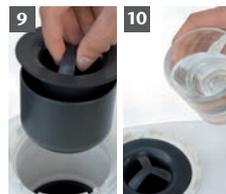
8 Anschließend kann der Geruchsverschluss wieder in den Befestigungsring gedrückt werden. Den Geruchsverschluss mit Wasser füllen.
