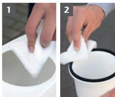
Die Lichtsacht-Entwässerungsöffnung innen- und außenseitig von Schmutz befreien. Die Dichtung des Grundkörpers säubern und dünn mit handelsüblichem Gleitmittel für Steckmuffensystem bestreichen.
