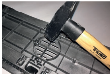
Ausschlagen der Bereichs für den Einsteckstutzen
