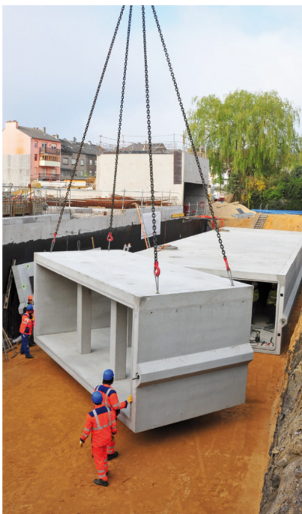
Einbau des Großbehältersystems
