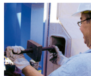
Verbindung mittels Spannstahl
