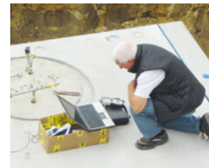
Druckluftprüfung auf Dichtheit
