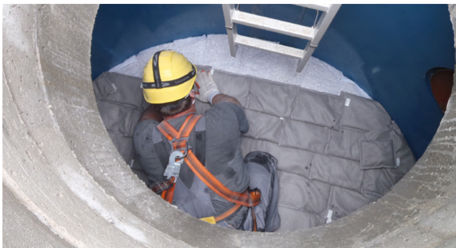
Einbau des Schwermetallfilters
