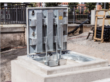
Sonderschachtabdeckungen mit Schutz vor Rückstau oder Überflutung
