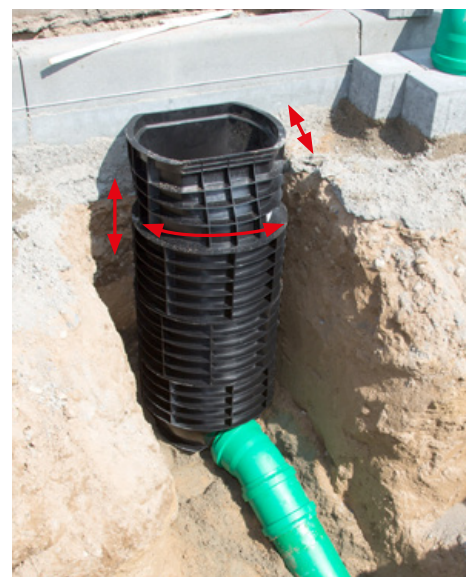
höhenverstellbar, drehbar, neigbar
