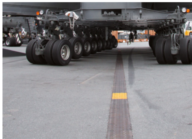
ACO PowerDrain eingebaut in Logistikflächen
