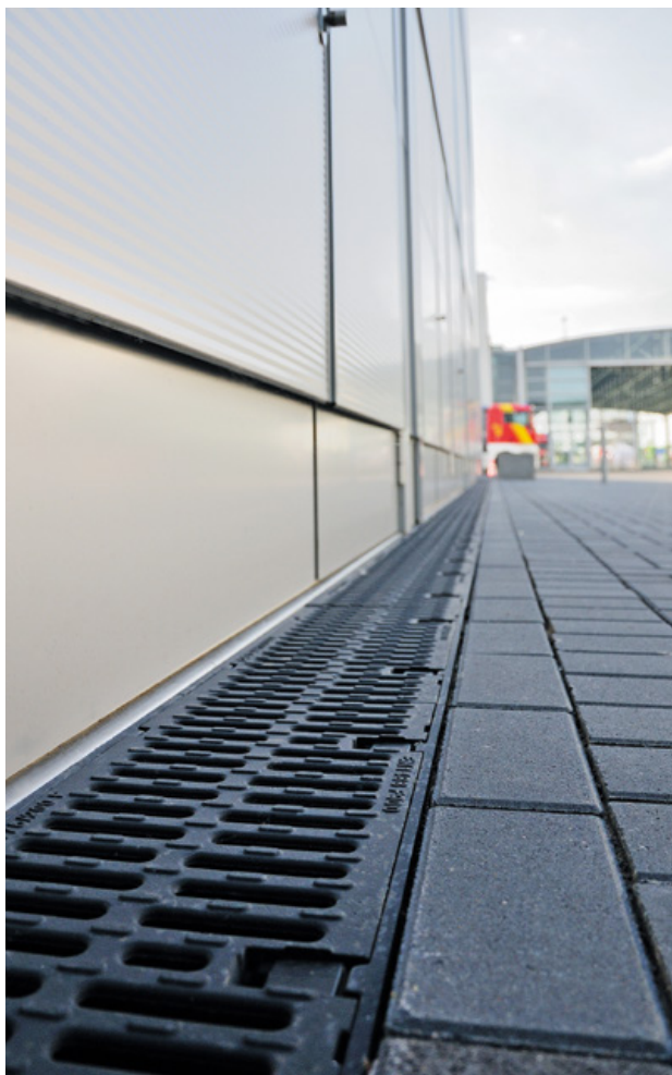
ACO PowerDrain im Außenbereich der Messe Hannover
