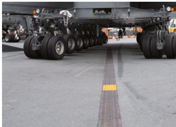
ACO PowerDrain eingebaut in Logistikflächen
