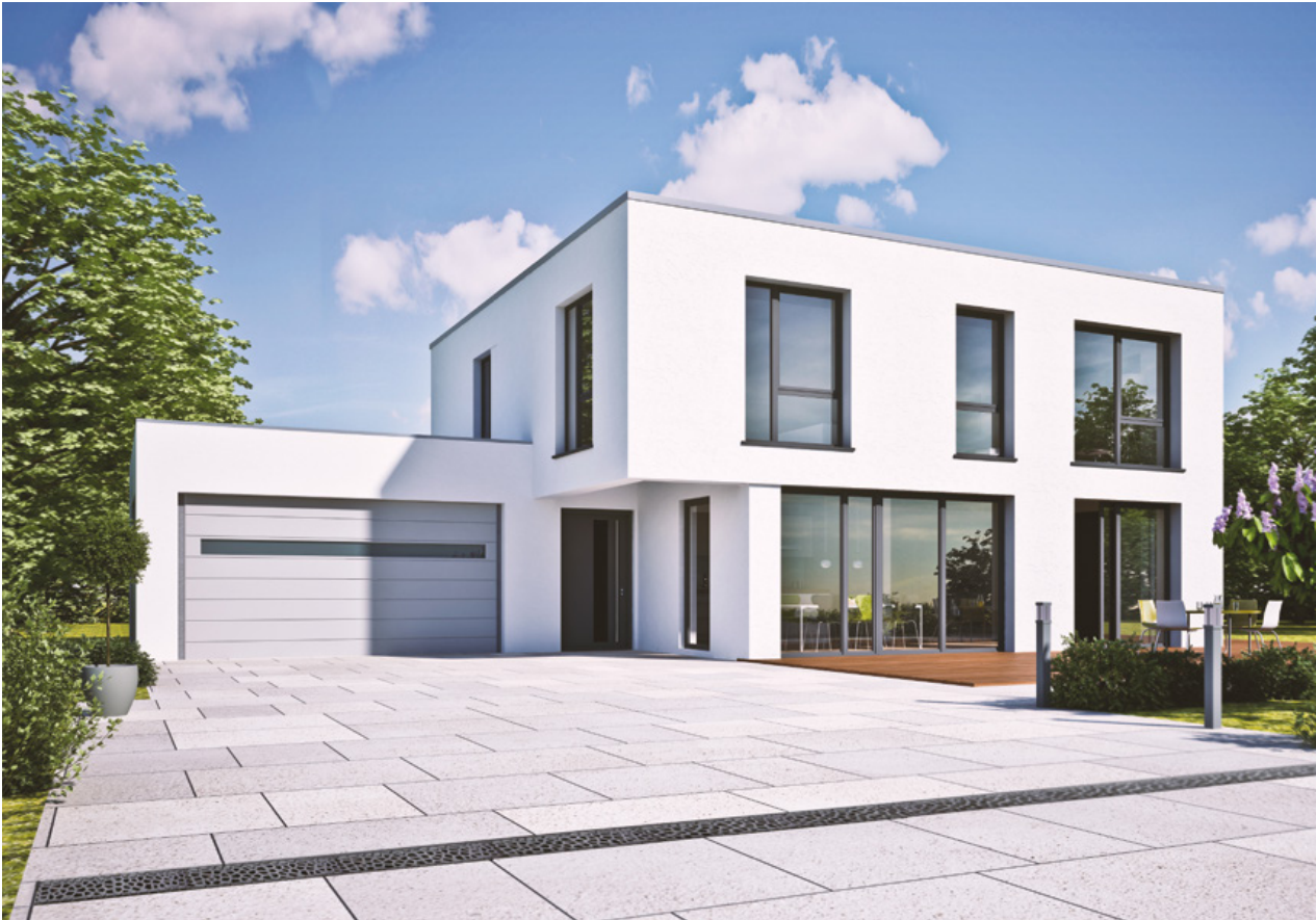
Grundstücks- und Garagenzufahrt mit ACO Self® Entwässerungsrinne
