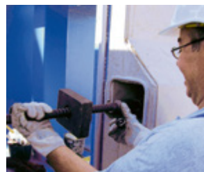
Verbindung mittels Spannstahl
