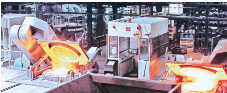
Moderne Mittelfrequenz- Induktions-Schmelzöfen, ACO Kaiserslautern
