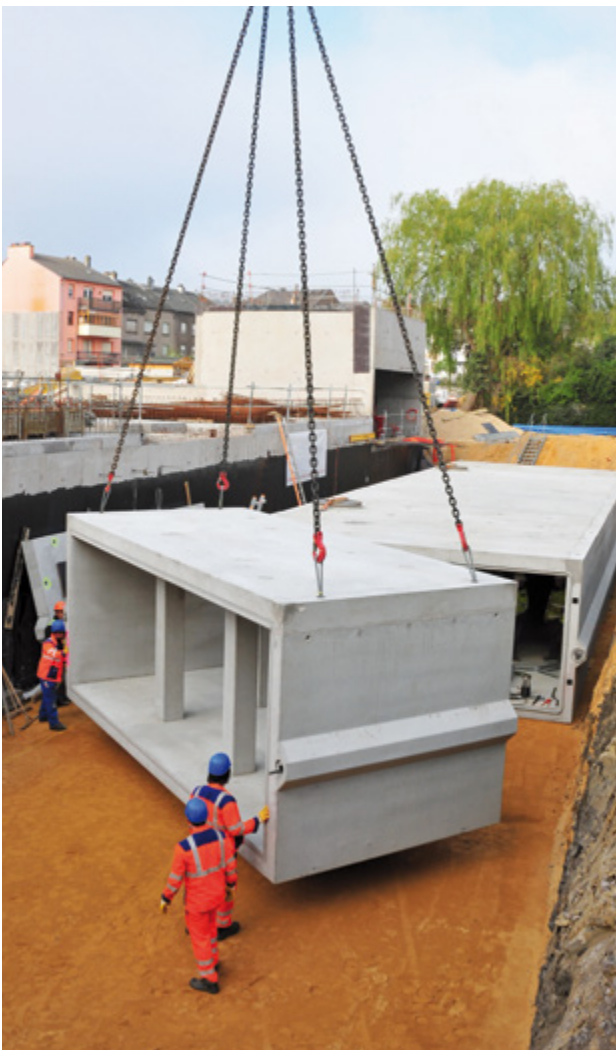
Einbau des Großbehältersystems
