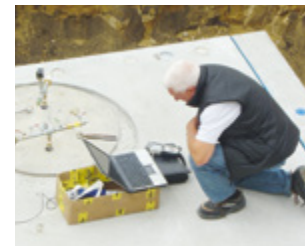
Druckluftprüfung auf Dichtheit
