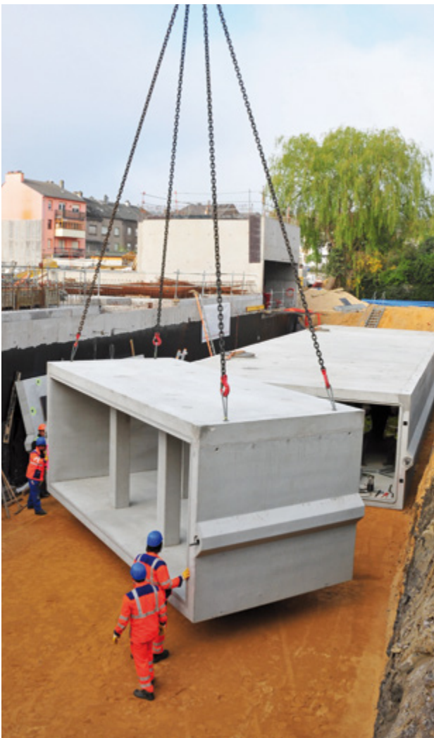
Einbau des Großbehältersystems
