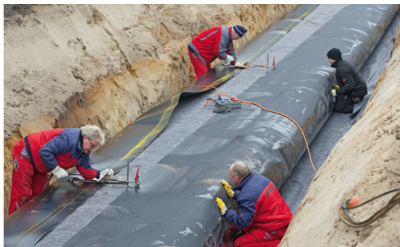
Das Blockspeichersystem wird mit einem inneren Schutzvlies und einer Abdichtungsbahn umhüllt
