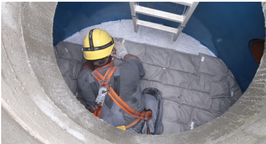
Einbau des Schwermetallfilters
