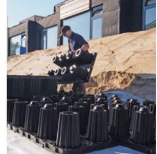
Das System wird aus Grundelementen aufgebaut, die im Verband verlegt werden
