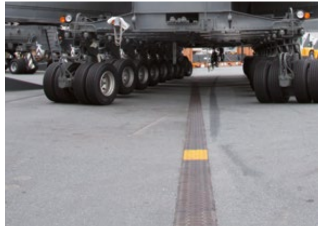
ACO PowerDrain eingebaut in Logistikflächen
