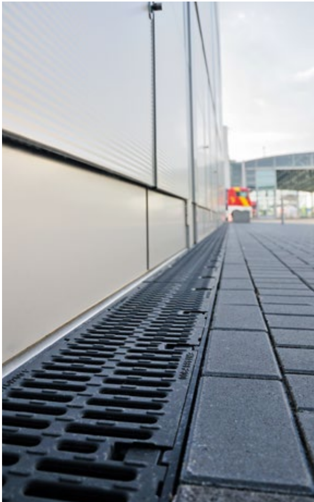
ACO PowerDrain im Außenbereich der Messe Hannover
