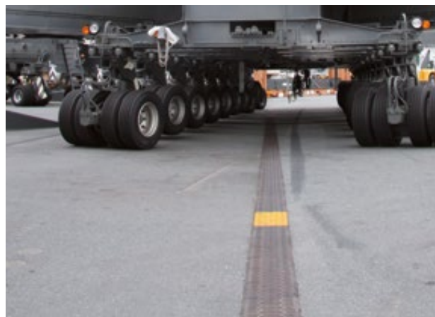
ACO PowerDrain eingebaut in Logistikflächen
