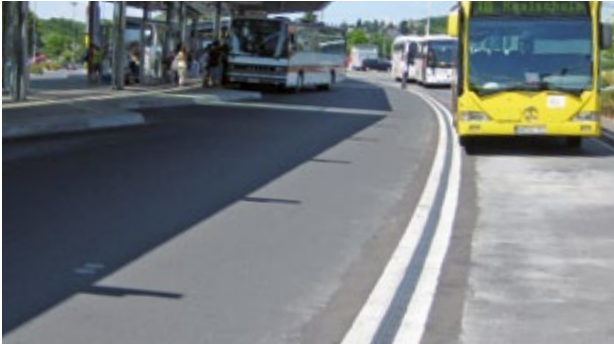
ACO PowerDrain an Busbahnhöfen
