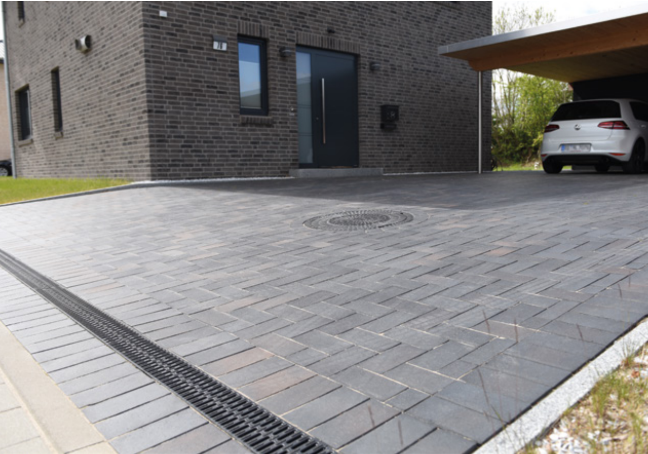
Kunststoffrinne Hexaline mit Microgrip-Rost
