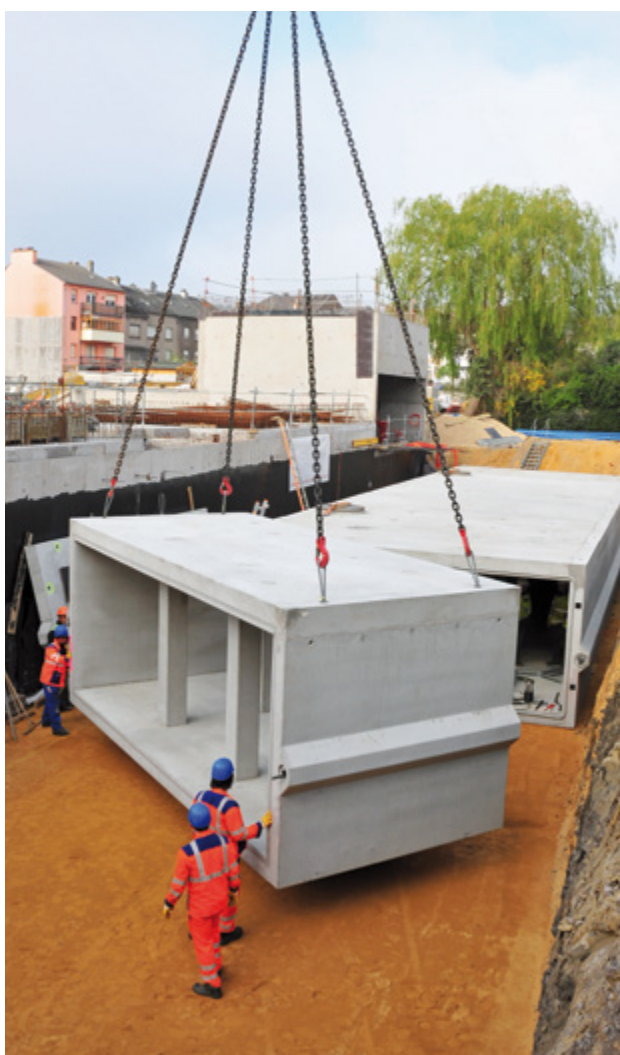
Einbau des Großbehältersystems
