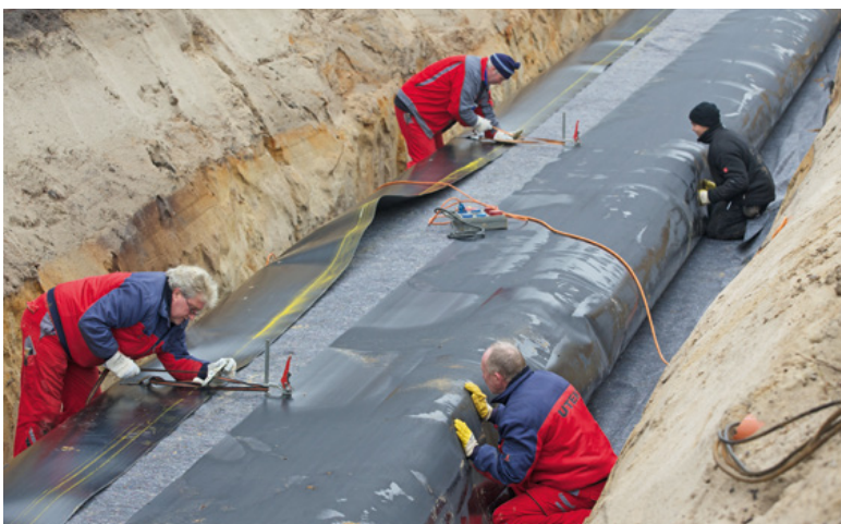
Das Blockspeichersystem wird mit einem inneren Schutzvlies und einer Abdichtungsbahn umhüllt
