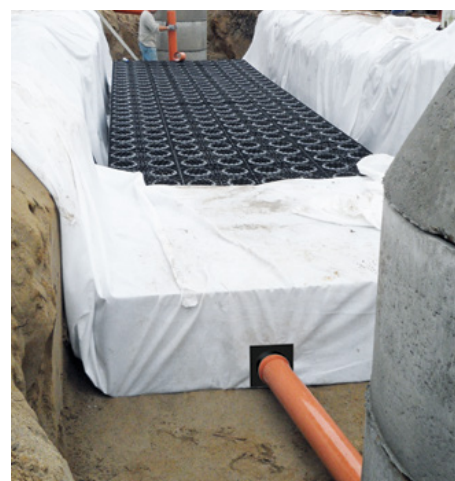
Zulauf von ACO Sedised-C über ein KG-Rohr mit ACO Adapter für Rohranschluss in die Rigole
