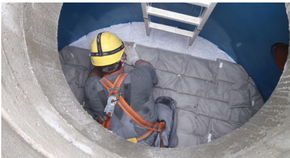
Einbau des Schwermetallfilters
