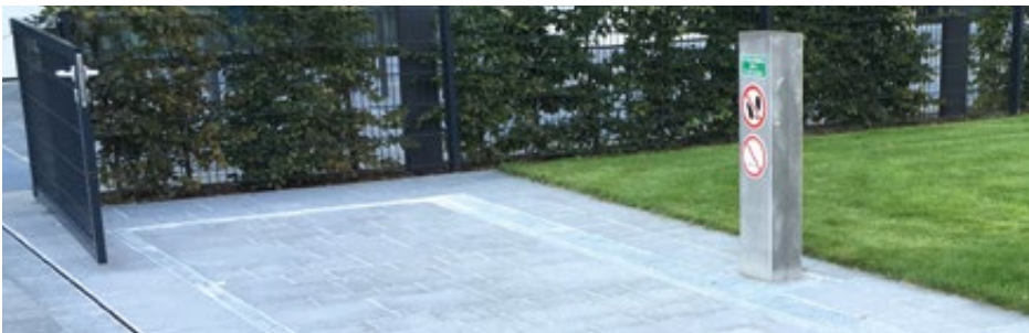
Sonderschachtabdeckungen bieten die Möglichkeit einer optischen Einpassung in das Gesamtbild
