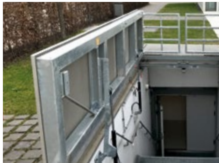
Großformatige, rechteckige Abdeckungen auf Bauwerksöffnungen
