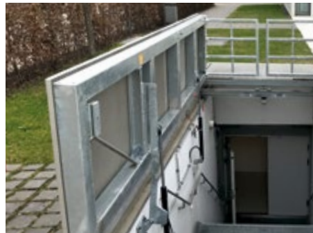
Großformatige, rechteckige Abdeckungen auf Bauwerksöffnungen
