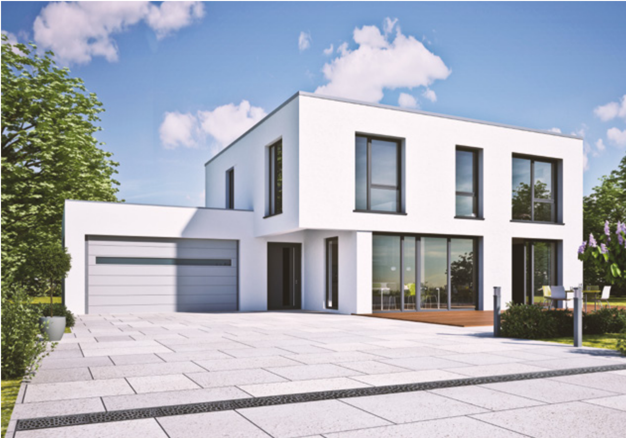
Grundstücks- und Garagenzufahrt mit ACO Self® Entwässerungsrinne
