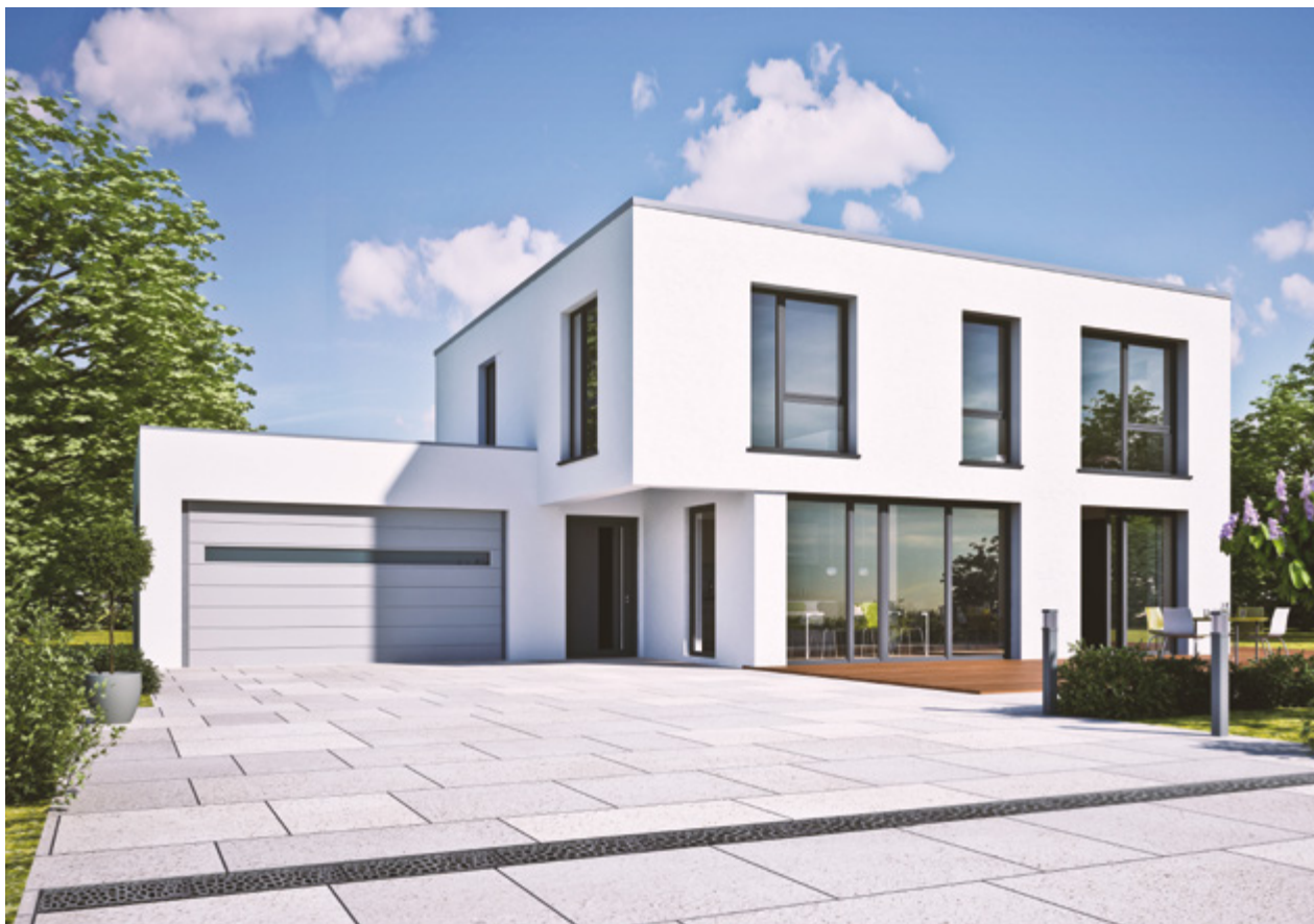
Grundstücks- und Garagenzufahrt mit ACO Self® Entwässerungsrinne
