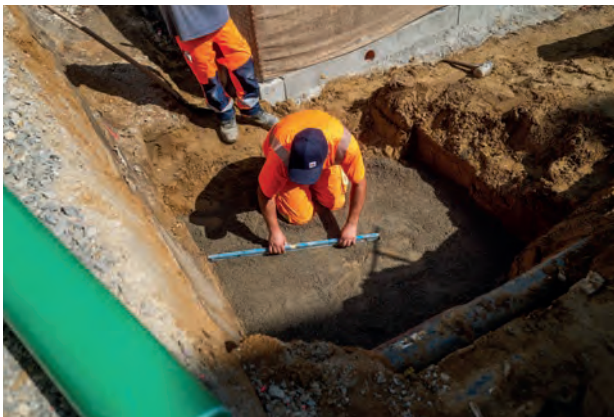
Baugrube Revisionschacht
