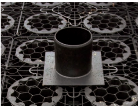
Der Rohradapter wird in die zuvor ausgeschnittene Öffnung nach oben montiert
