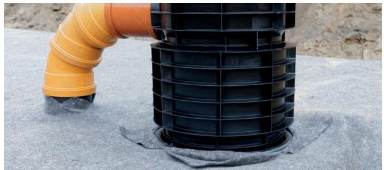
Das Geotextil wird eingeschnitten und über den Rohradapter geschoben
