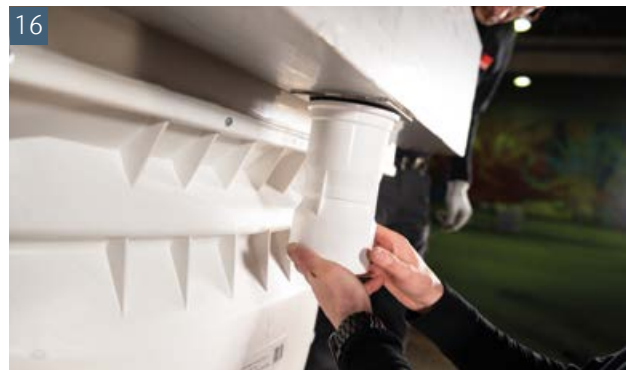
16 Bringen Sie nun den Entwässerungsanschluss bzw. Rückstauverschluss an und schließen diesen an die Entwässerungsleitung an. Bitte beachten Sie hierbei die Installationshinweise der beigegeführten Einbauanleitung
