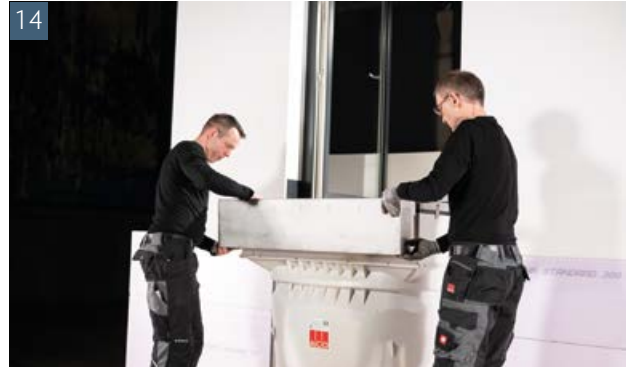
14 Nehmen Sie den Lüftungskasten zur Hand und führen Sie den Lüftungsstutzen in die Aussparung des Aufstockelementes ein
