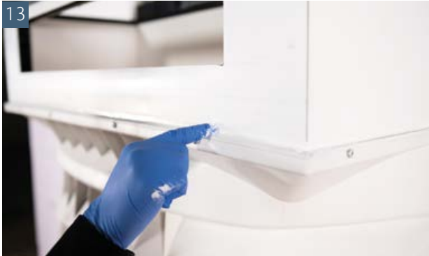
13 Nach dem Ausfügen können Sie mit der Montage des Lüftungskastens fortfahren
