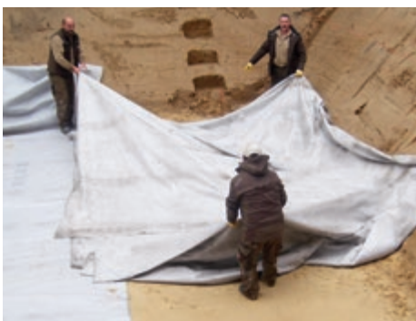
Nach Erstellung des ebenen, stein- und gefällefreien Planums wird die Baugrube mit einem Filtervlies ausgelegt
