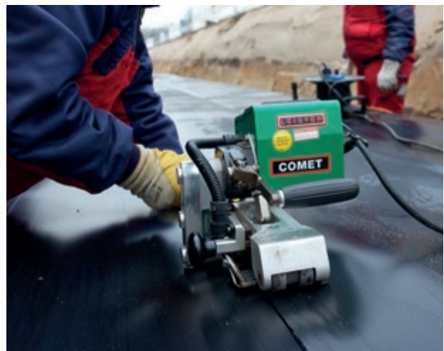
DVS-geprüfte Schweißer verbinden die Dichtungsbahnen professionell mit einem Heizkeilschweißgerät
