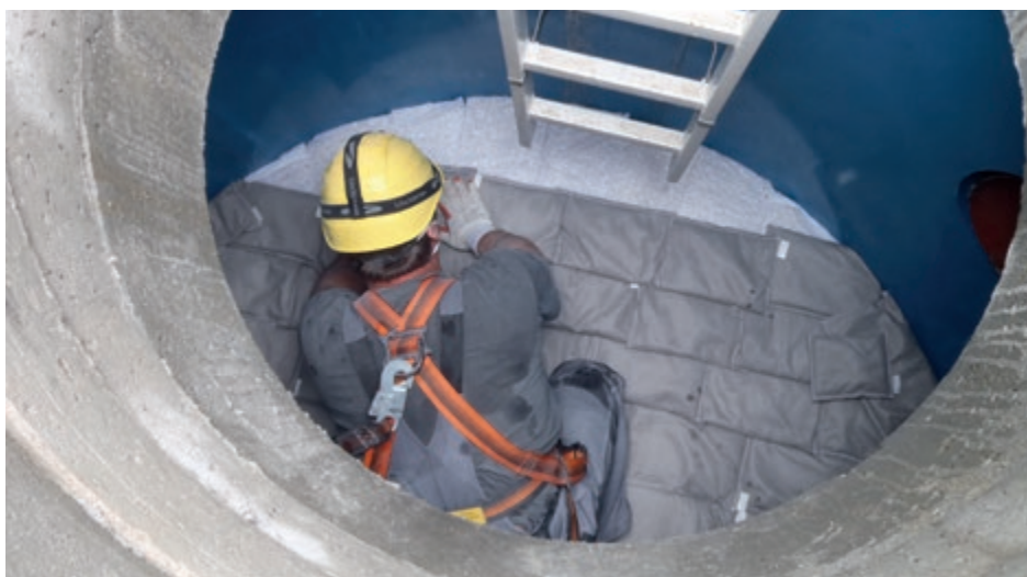
Einbau des Schwermetallfilters
