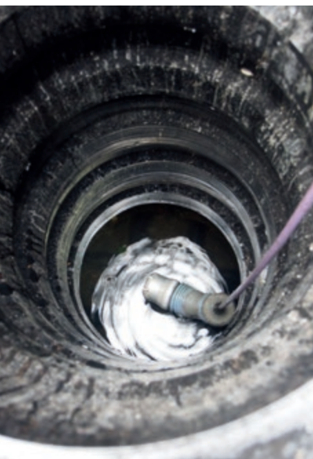
Vertikaler Zugang direkt über der Rigole
